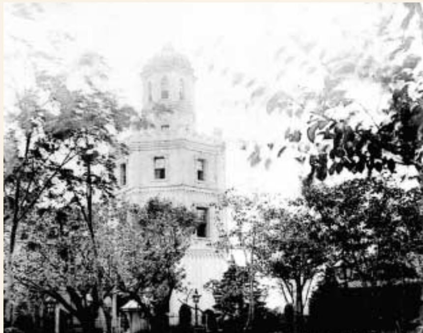
「愛宕山ノ高塔」 明治26年(1893) 東京景色写真版 在りし日の愛宕館と展望塔。国立国会図書館ウェブサイトより転載
