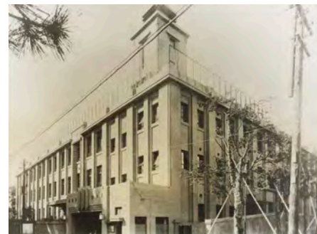
上の写真は、1932(昭和7)年、現在も残る校舎が竣工した直後に撮影された。関東大震災の経験と、前の校舎が不審火で焼失したことから、東京都は耐震・耐火の鉄筋コンクリート建築を採用した。
